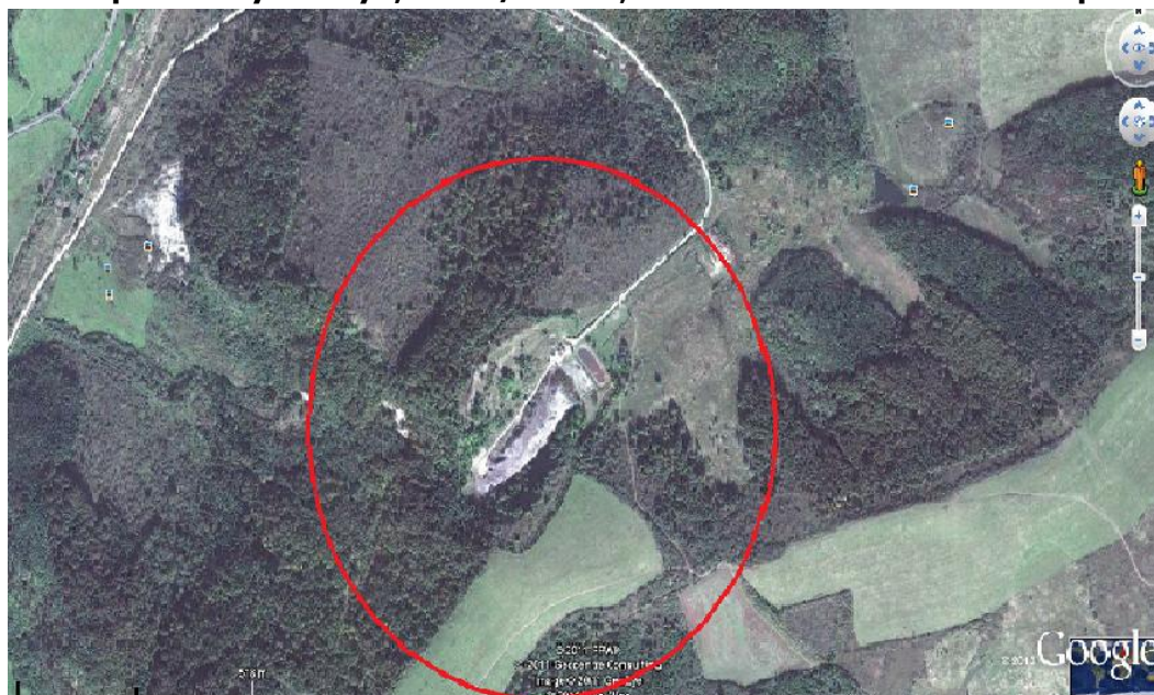
11. kép: Bátonyterenye, 0195/2 hrsz, szilárd hulladéklerakó telep
