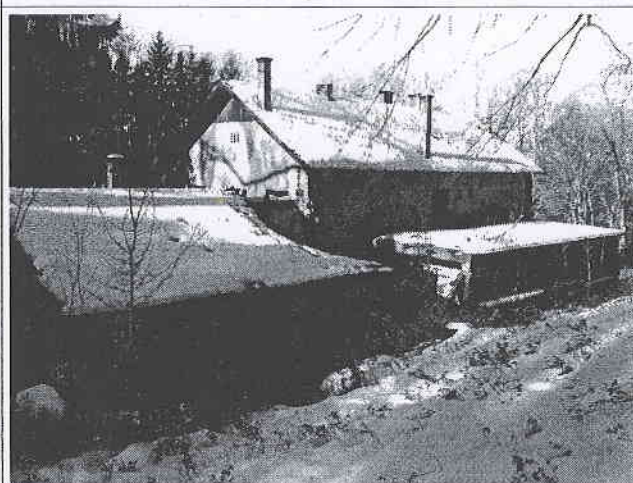
Fotó – toldott épületszárny keletről
