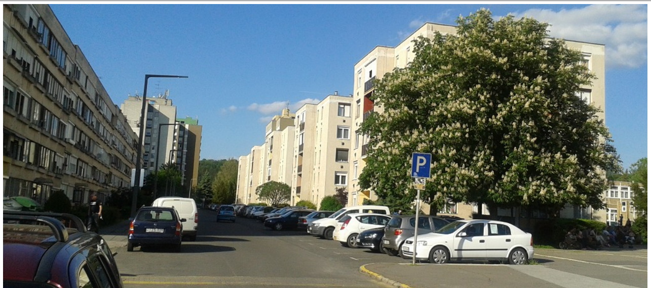
Ybl Miklós út, jobbra a kohóhabsalak blokkos, az út végén és balra a monolit alagútszalus vasbeton építésű társasházak
