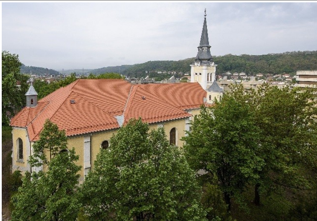
Főplébánia templom, tetőfelújítás 2017-ben
