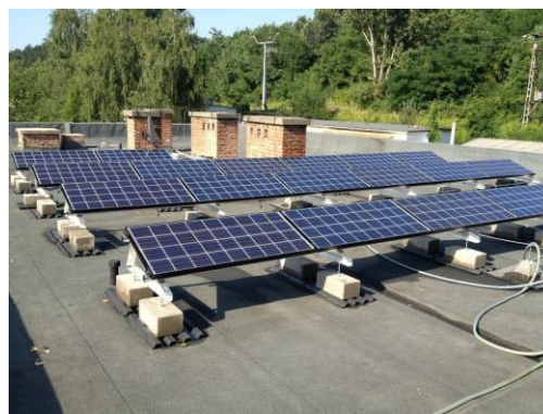
8. ábra: 2,8 kW-os szigetüzemű rendszer Salgótarjánban egy családi ház tetején.
