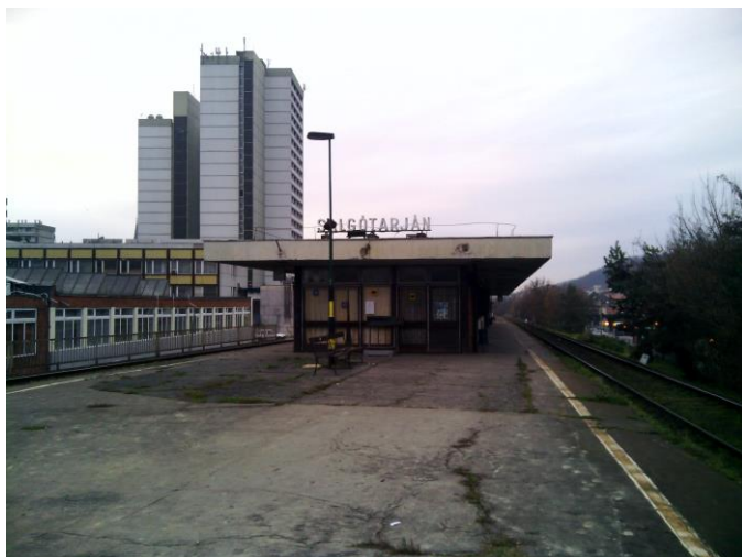
44. ábra Salgótarjáni belvárosi vasútállomás
