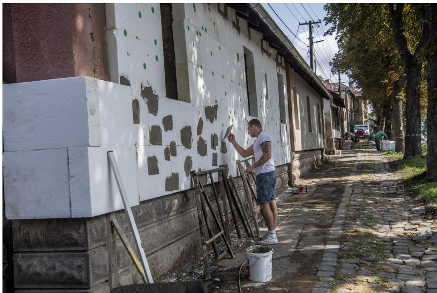
35. ábra Felújításra kerülő szegregátumban található szociális bérlakás a Salgó úton
